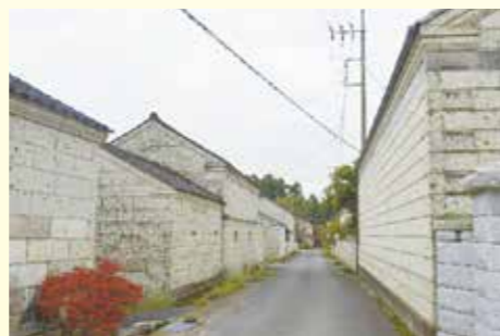
芦沼集落(大谷石建造物の街並み)
