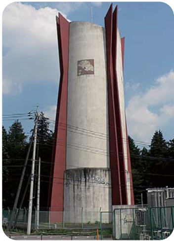
西部地区 下荒針配水場
