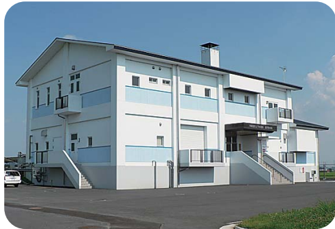
北部地区 白沢浄水場
