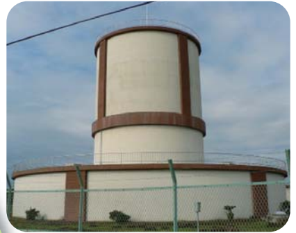
東部地区 板戸配水場
