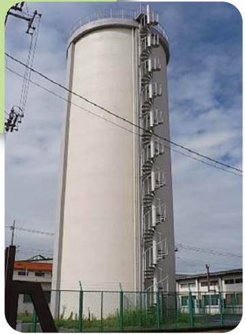
南部地区 瑞穂野応急給水所
