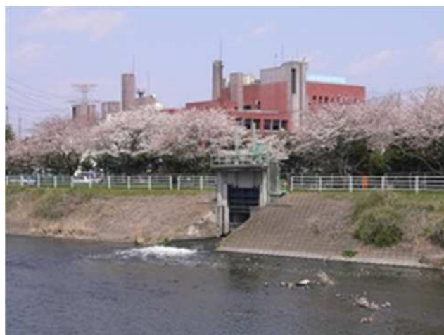
川田水再生センター
