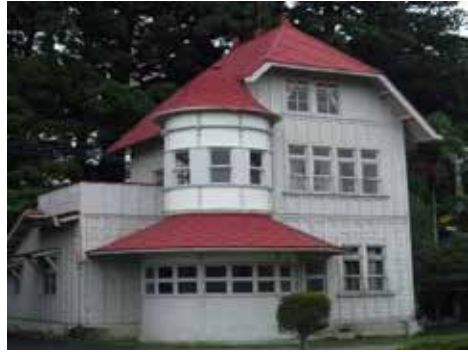
今市浄水場旧管理事務所
