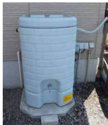
宅地内雨水貯留施設
