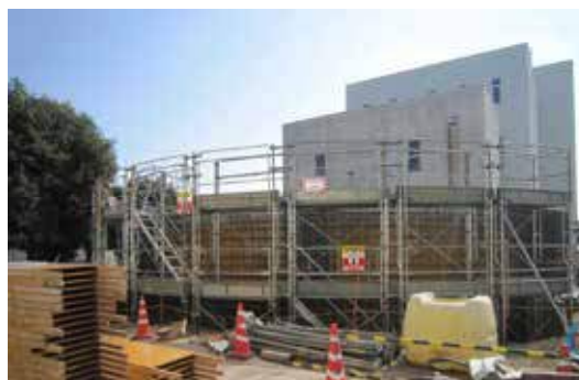
川田水再生センターの設備更新工事
