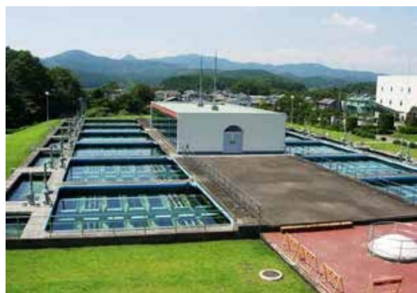
松田新田浄水場
