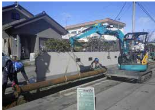
老朽配水管の布設替工事
