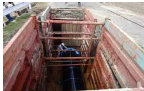
導水管の耐震化工事
