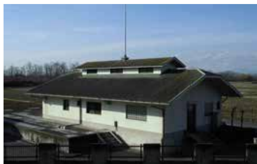
農業集落排水処理施設
