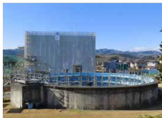
松田新田浄水場の設備更新工事
