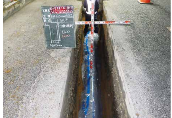
老朽配水管の布設替工事
