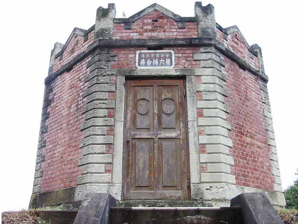
第6号接合井 (登録有形文化財・土木学会選奨土木遺産)
