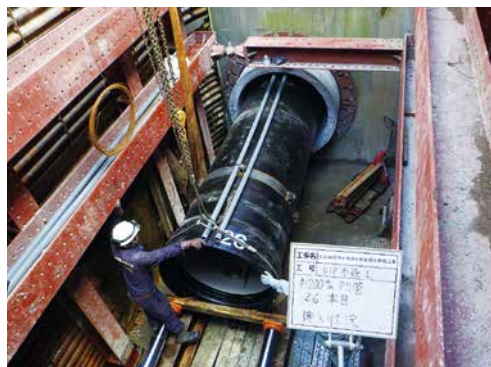
導水管の耐震化工事
