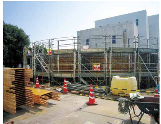
川田水再生センター設備更新工事
