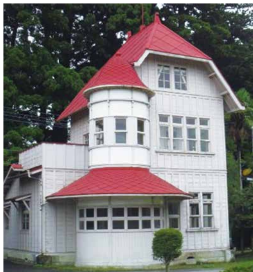
今市浄水場旧管理事務所
