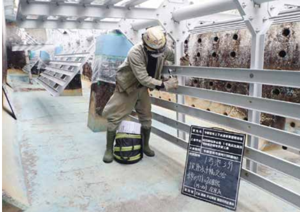
松田新田浄水場の設備更新工事
