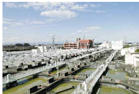
川田水再生センター
