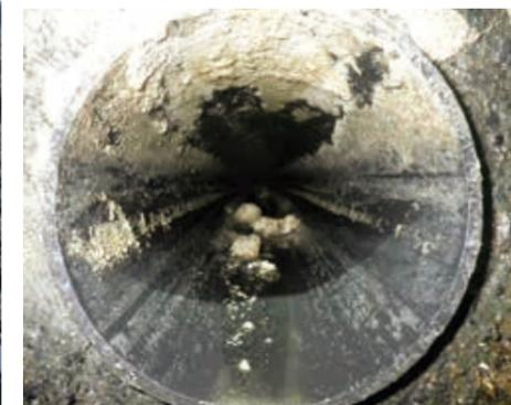
油が付着した下水道管内部
