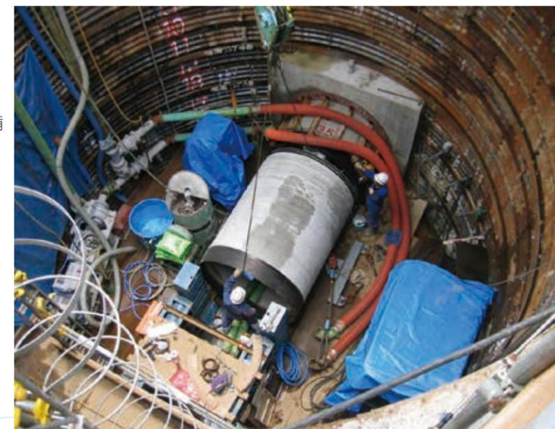
雨水を流す下水道管を設置する様子
