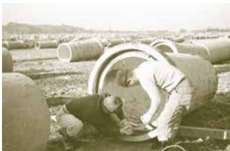
昭和31年 導水管を敷設する様子
