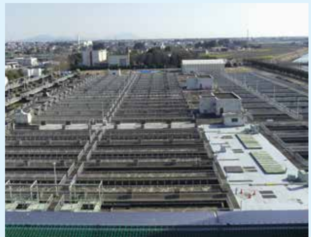
川田水再生センター
