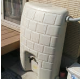
雨水貯留タンク
