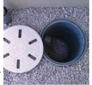
雨水浸透ます
