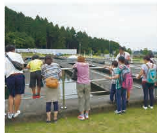
松田新田浄水場での様子
