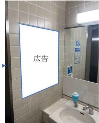
④ 1階北側女性用トイレ内(洗面台横壁面)
