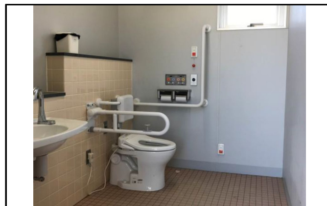
画像2（トイレと手すりの位置がわかるよう撮影）
