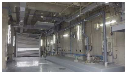
(写真：川田水再生センター 浄化槽汚泥等受入施設)
