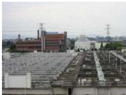
(写真：川田水再生センター)
