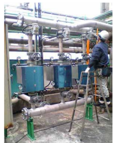
— 工場に設置されている発電機と水車 —
