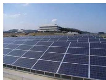
松田新田浄水場
