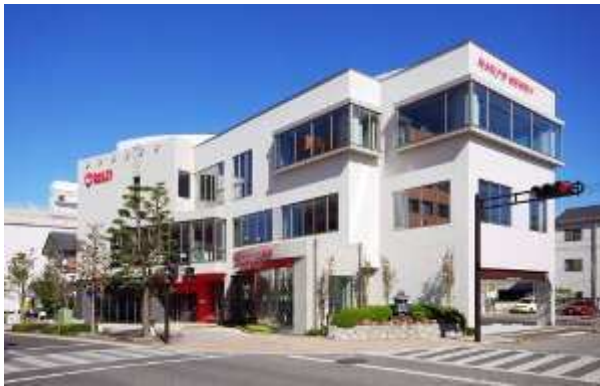
◆景観賞 大賞◆ エフェム栃木本社屋（川上ビル）
