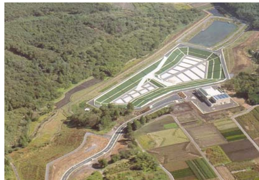
■エコパーク板戸（最終処分場）
