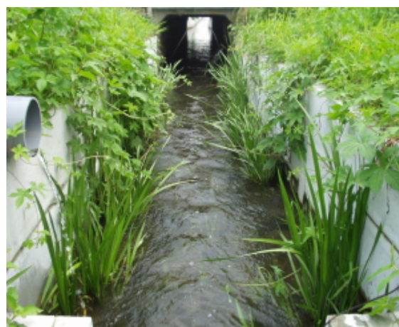
■生態系に配慮したかんがい排水路 (天神水路)
