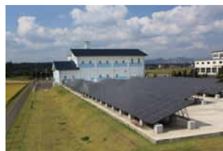
白沢浄水場(太陽光発電システム)
