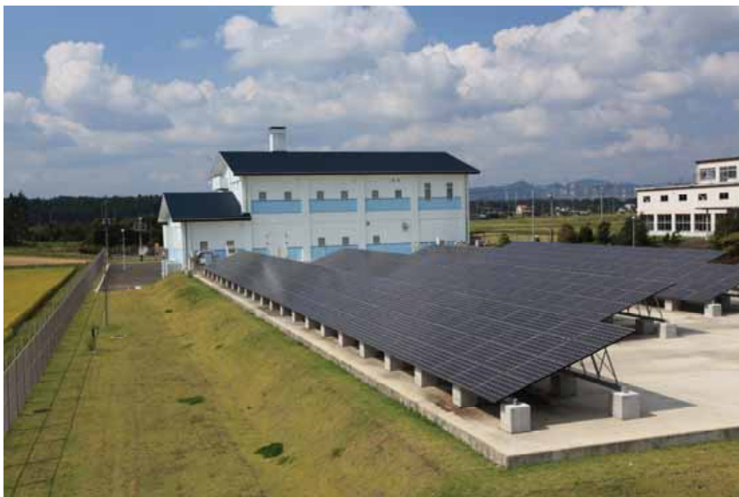
白沢浄水場（太陽光発電システム）
