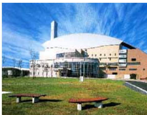
クリーンパーク茂原（焼却ごみ処理施設）
