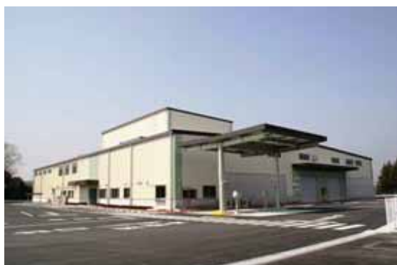
エコプラセンター下荒針（リサイクル施設）
