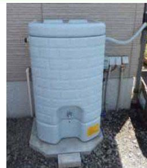
宅地内の雨水貯留タンク
