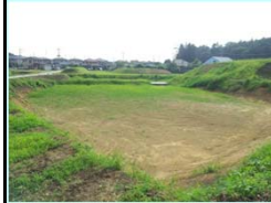
基幹事業: 地域生活基盤施設 調整池(地域防災施設)
