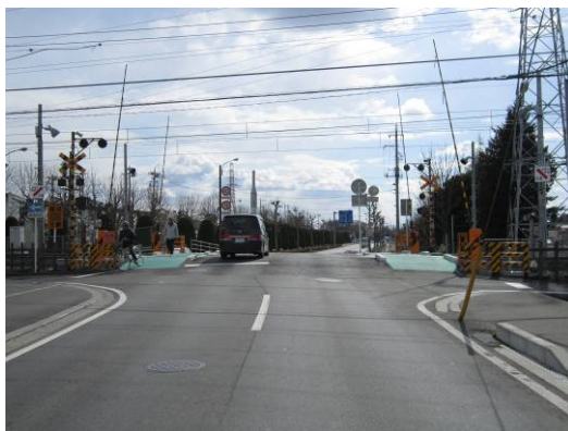
踏切改良工事：第二板戸踏切(市道 544 号線)
