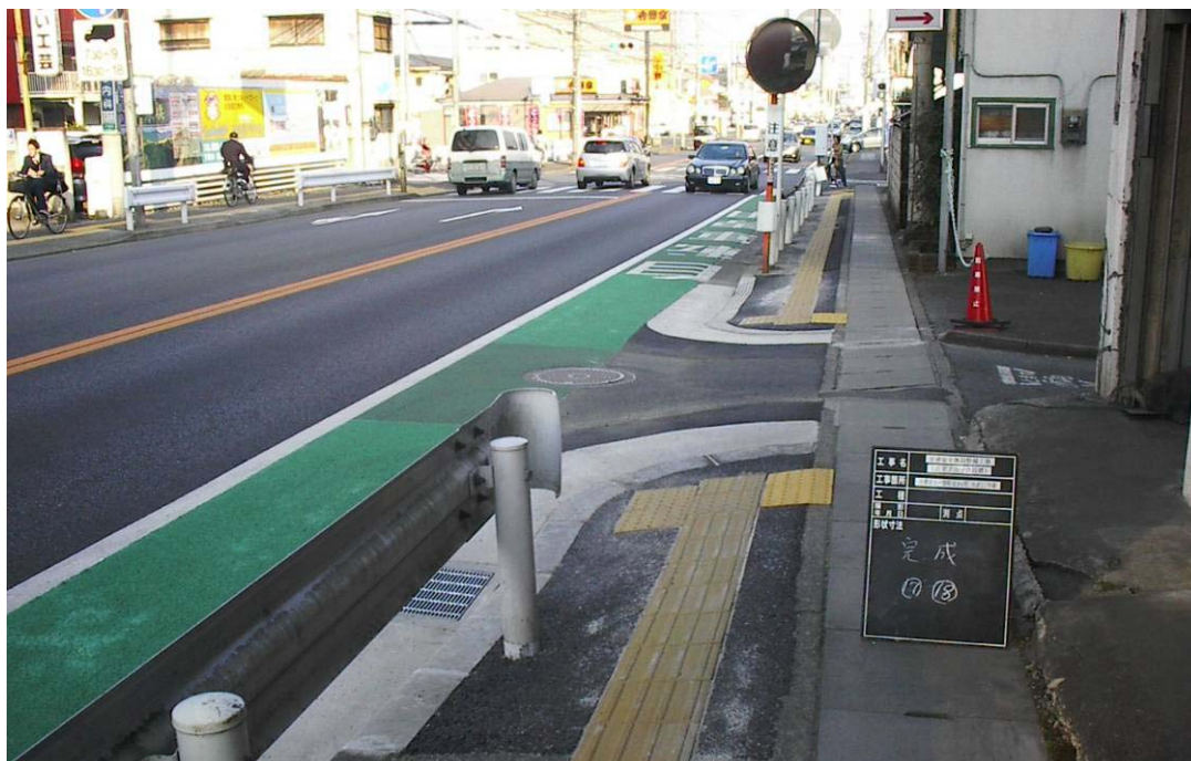
歩道縁端部段差の解消と点字ブロックの設置
