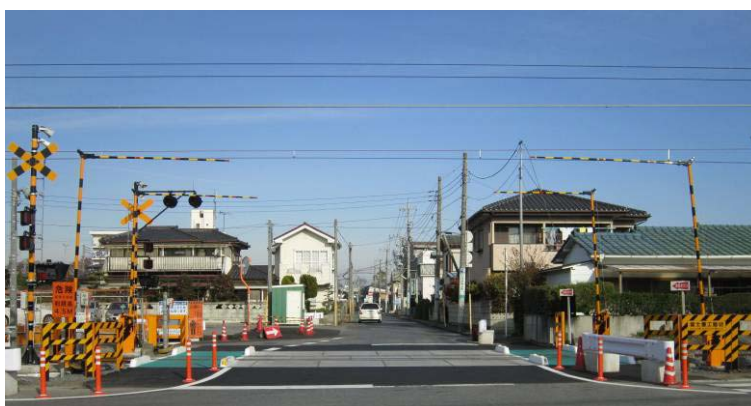
踏切改良整備（歩道確保）
