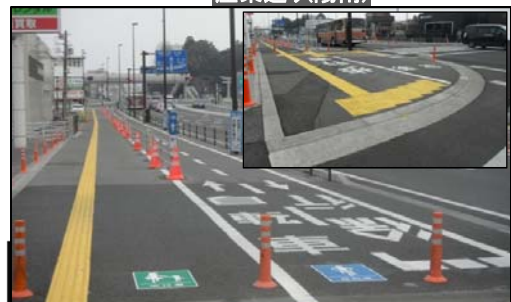
Ⅲ-3-④ 道路バリアフリー事業の推進 (H25 大通り 自転車歩行者の分離、 点字ブロック敷設、交差点の段差解消)
