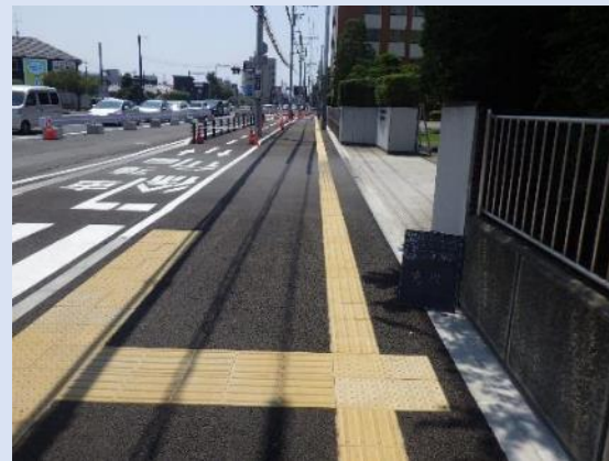
電線類地中化工事(宇都宮栃木線)
