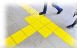
誘導ブロック
