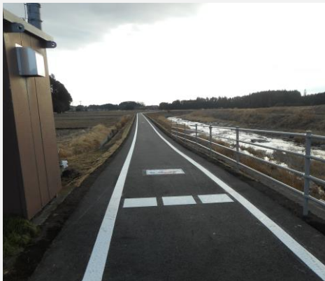
▶ 舗装整備と路面標示
