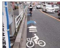
車道混在 (矢羽根型路面表示)
