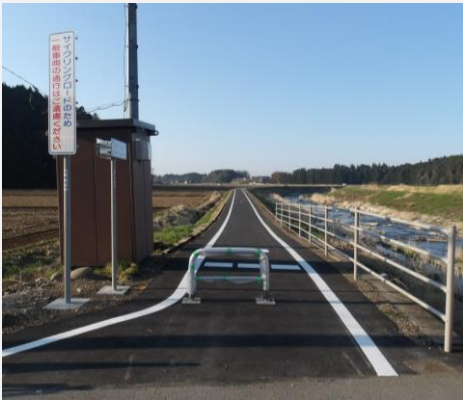
▶ 車止めと案内標識
