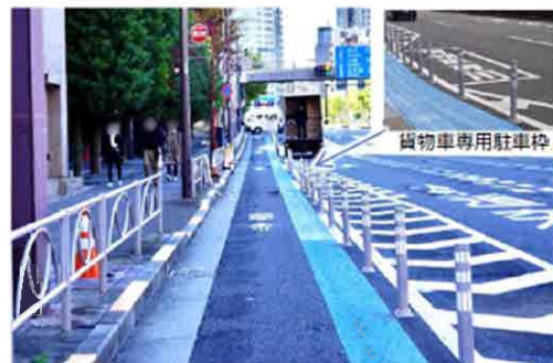
自転車専用通行帯の整備区間にゴム製ポールと貨物車専用駐車枠を設置
