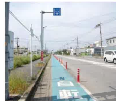
自転車専用通行帯にゴム製ポールを設置
