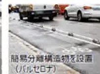
自転車専用通行帯にゴム製ポールを設置
