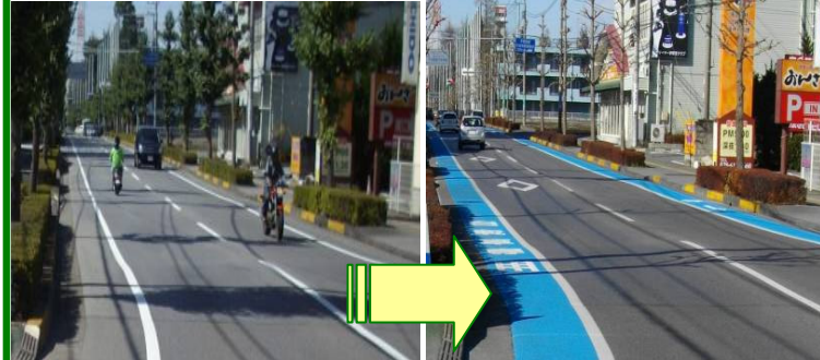
白楊高通り(市道920号線)の整備前後比較
