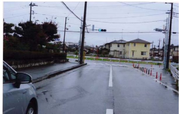
交通信号機の新設
