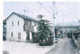
(第 7 班住宅・右奥が北道路)
