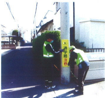
看板設置作業
