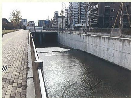
現在の同じ場所。改修工事で容量が増えた。ごみを全自動で取り除く装置も設置されている。
