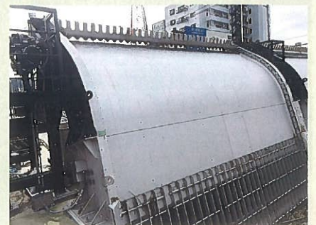
現在の同じ場所。改修工事で容量が増えた。ごみを全自動で取り除く装置も設置されている。
