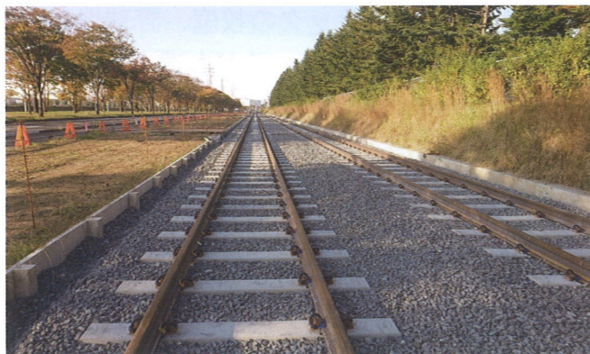
清原工業団地内のレール工事
