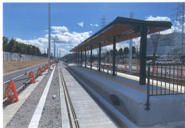
LRT清原工業団地北停留場
