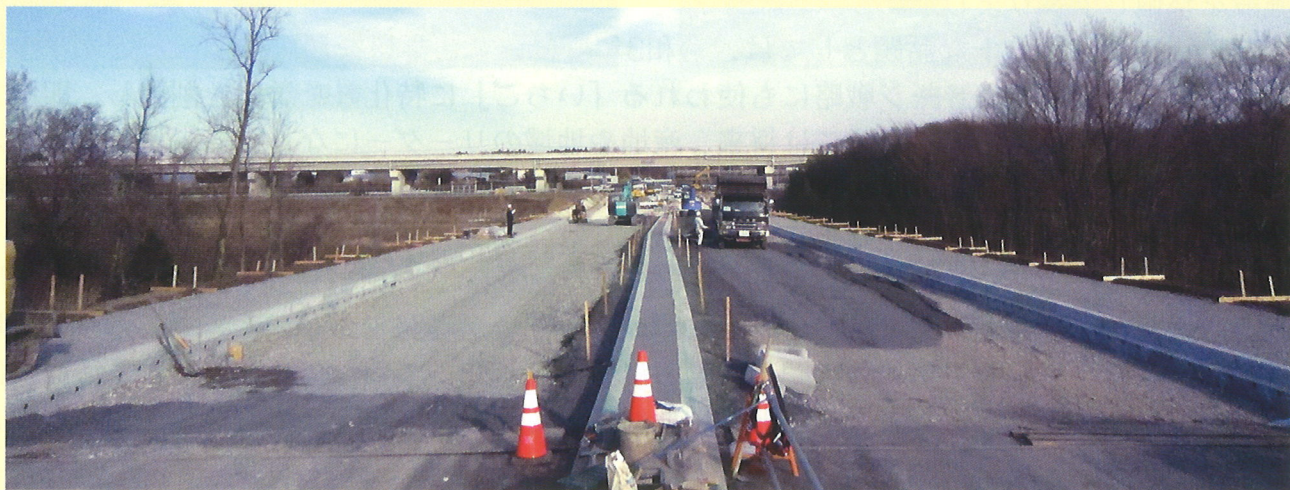
上籠谷町地区内 408バイパスを望む 令和3年3月26日開通予定
