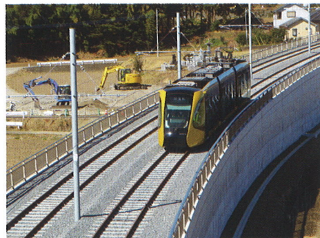
試運転 国道408号から
