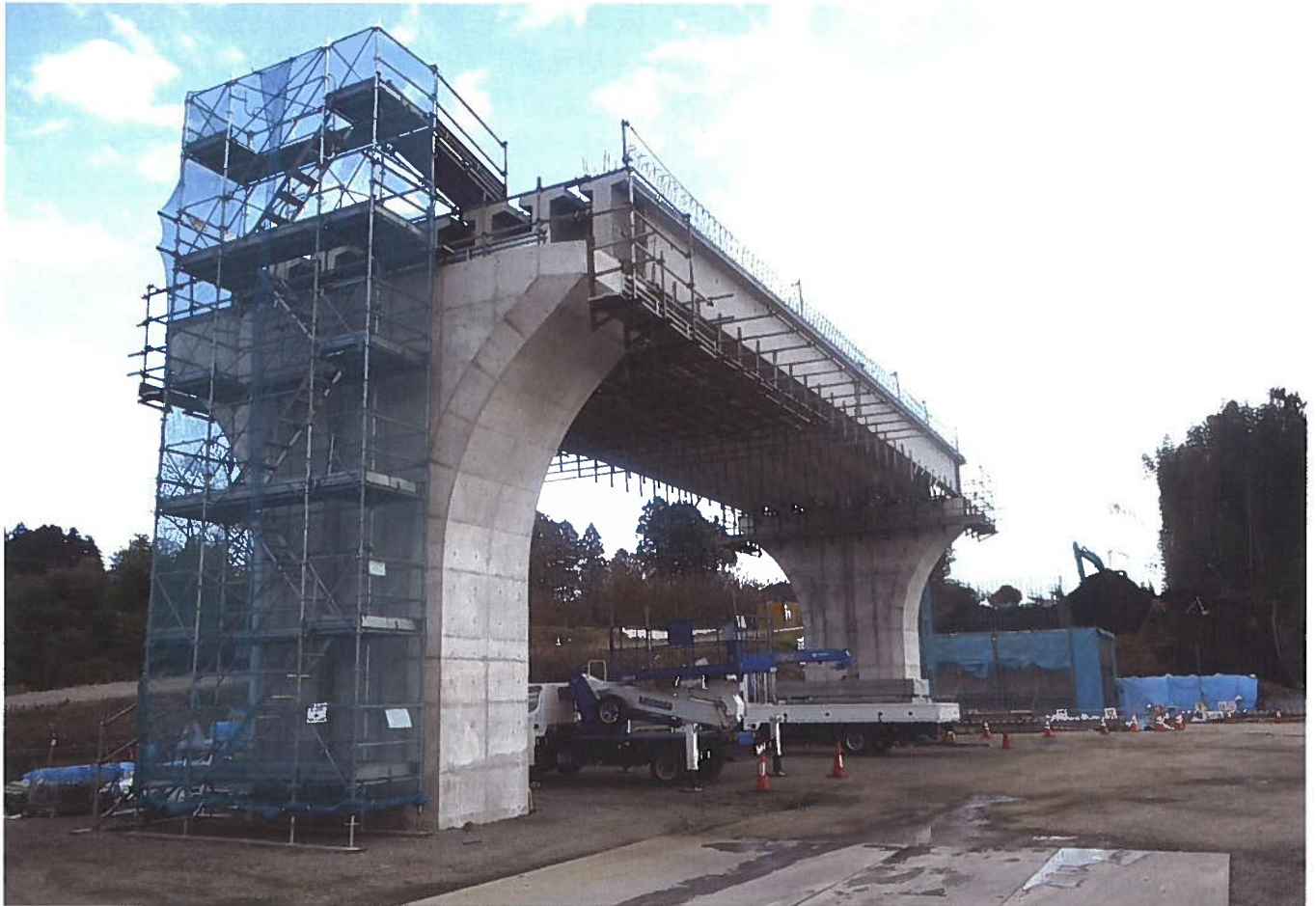
LRT整備工事（仮称）下竹下停留場周辺の橋りょう
