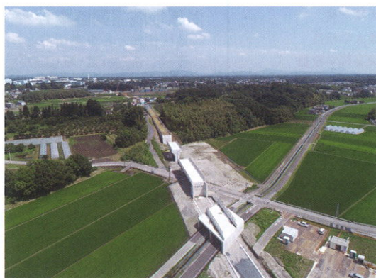
LRT工事 仮称下竹下停留所付近
