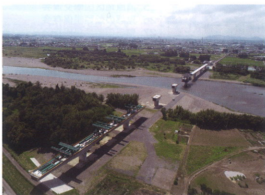
LRT 鬼怒川左岸寄り橋梁工事風景
