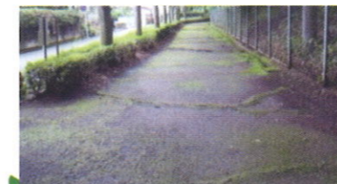
(写真1) ピフォア（修繕工事前）
