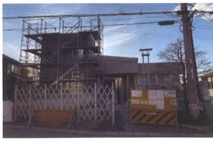
↑ コミセン工事中 (2020.2.19 現在)
