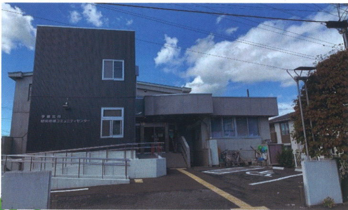
※昭和地域コミュニティセンターのエレベーター設置工事が完了しました。
