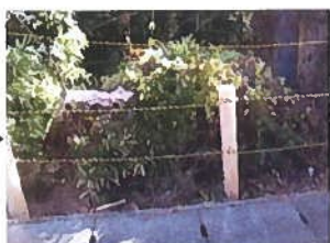
(写真2) 修繕工事後
