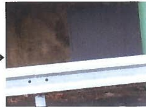
(写真4) 修繕工事後
