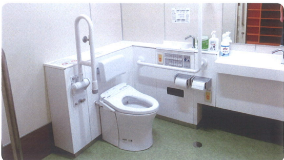
多目的トイレ
