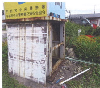
内部点検の様子
