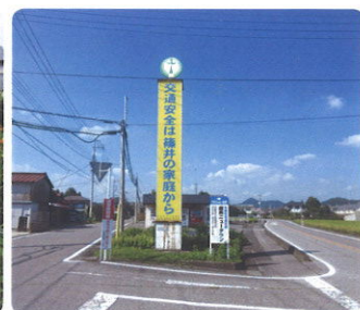
補修が完了した塔看板
