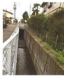
3 戸祭小東側の暗渠入口
