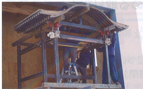
2 階部分の組み立て
