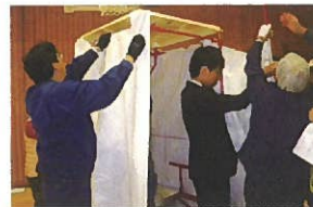
仮設トイレの設置
