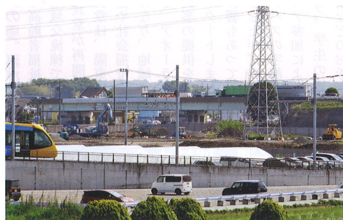
桜台第1児童公園から工事現場を望む(2025.5.16撮影)
