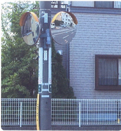
カーブミラーの向きのずれ
